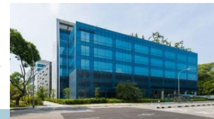
アセンダス・リートが取得した「DNV GL Technology Centre」
