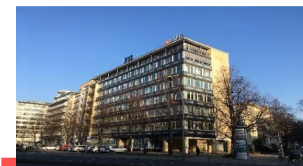
アルストリア・オフィス・リートが取得した オフィスビル
