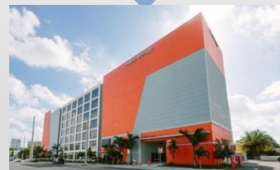
第5世代の物件例 2016年に竣工したフロリダ州の物件 (賃貸可能床面積：約1.5万平方メートル、 倉庫数：2,040)
