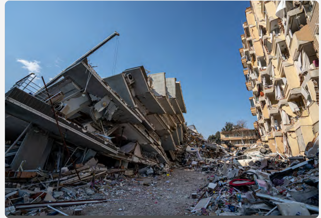
2023 年トルコ・シリア地震で倒壊した建物
