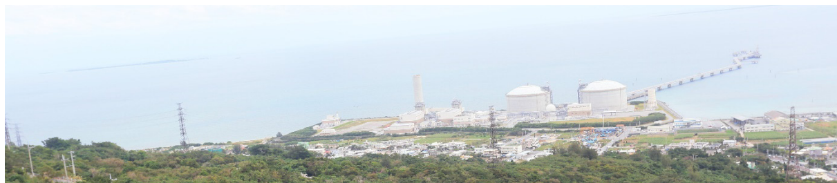
沖縄電力吉の浦火力発電所(沖縄県中城村)
